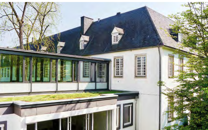
Begrüntes Dach im Evangelischen Kirchenverband Köln und Region
